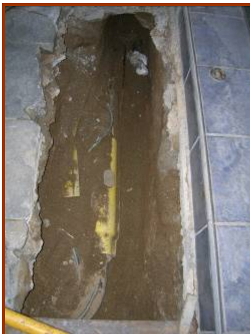
Fotografia 4. Rasa 100 amb diversos serveis anteriors a la seva obertura
